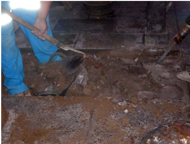
Detall de l'extracció del paviment del carrer i de la capa de formigó
